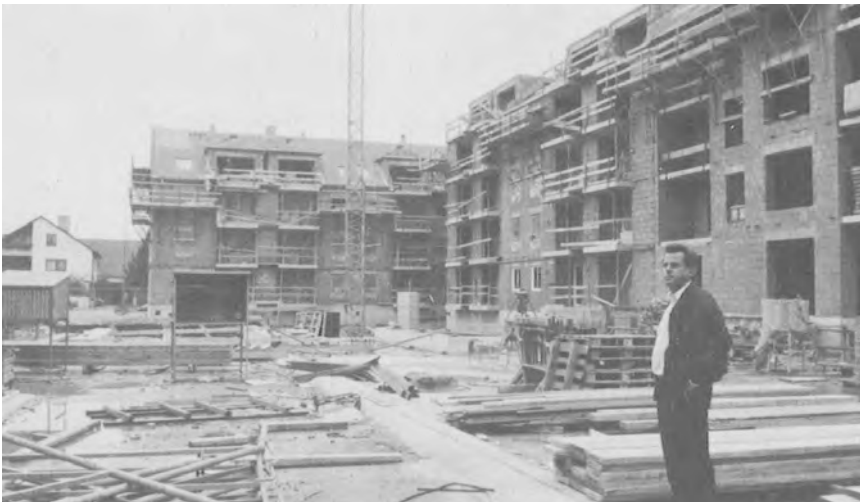
Eigentumswohnungen an der Dr.-Schmelzing-Straße.
