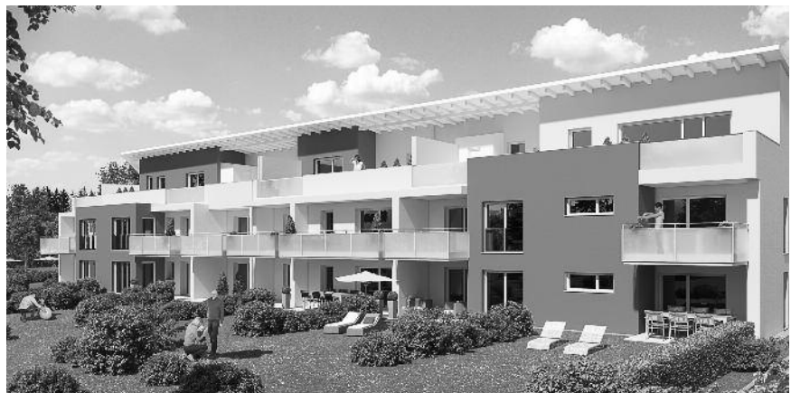
Bauvorhaben an der Friedl-Urban-Str.
