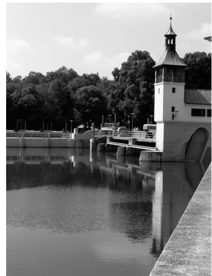
am Hochablass entsteht ein neues Wasserkraftwerk
