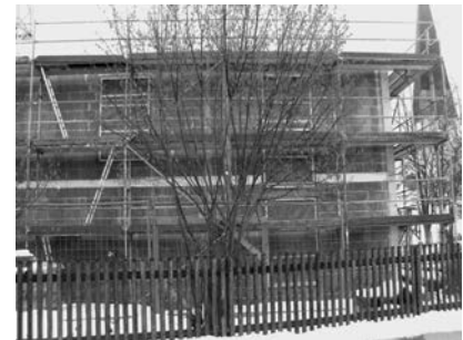
Rohbau des Kindergartenbau
