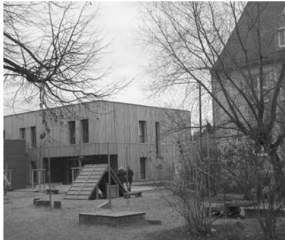
Mit dem neuen Anbau des Kindergartens der Pfarrei Christkönig hat sich auch die Betreuungssituation bei uns in der Hammerschmiede sehr verbessert.
